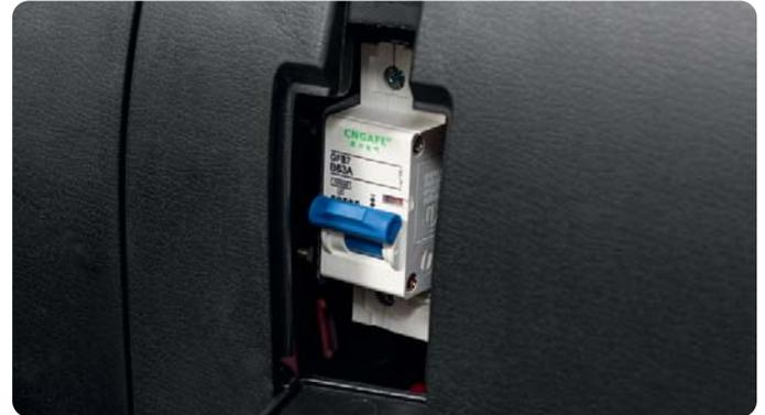
Abb. 1.24 Hauptsicherung
